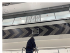
高所施工状況
